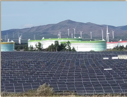
ソーラーパネルと石油タンク、風力発電の風車
